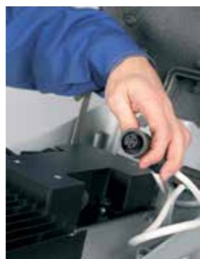
Вывинчивание гаек, крепящих ПРА к светильнику, и отключение питания без применения инструментов
