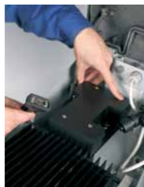
Вывинчивание гаек, крепящих ПРА к светильнику, и отключение питания без применения инструментов
